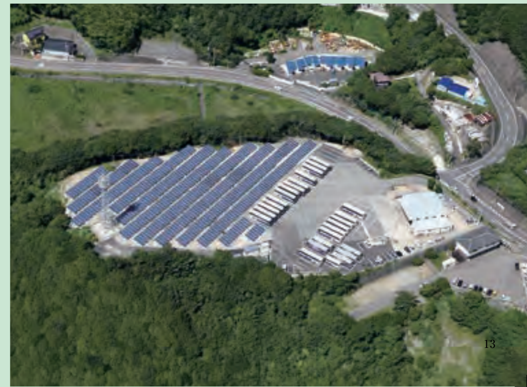
鳴見車庫の太陽光発電
